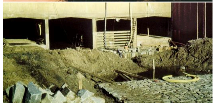
Die Aue erhält im Anschlussbereich ein gepflastertes Bett.
