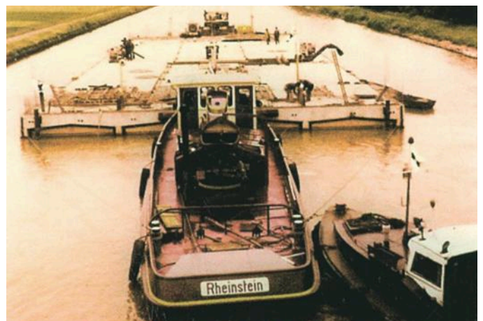
Der Durchlaß ist fertig und wird schwimmfähig gemacht. Seitenböschung zum Kanal wird geöffnet. Im Hintergrund der Sportplatz von Kolenfeld am Mühlenweg.
