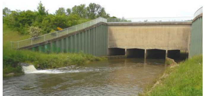
Der fertige neue Auedurchlass 1979.
