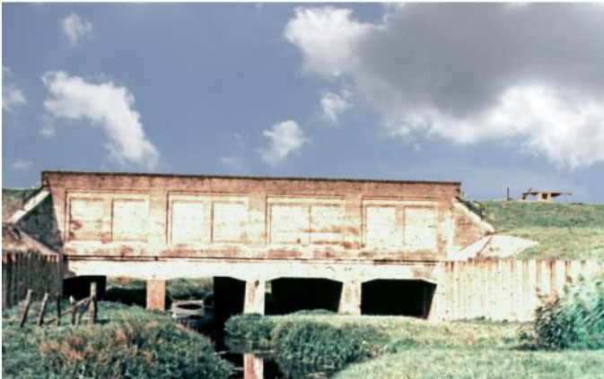
Der alte Auedurchlass. Aufnahme Anfang 1950er Jahre.
