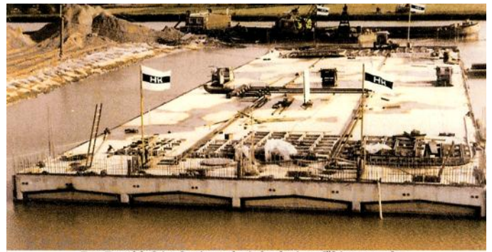
Der Durchlaß ist fertig und wird schwimmfähig gemacht. Seitenböschung zum Kanal wird geöffnet. Im Hintergrund der Sportplatz von Kolenfeld am Mühlenweg.
